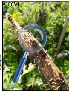
Bois extérieur attaqué par des termites. Contamination par le sol
